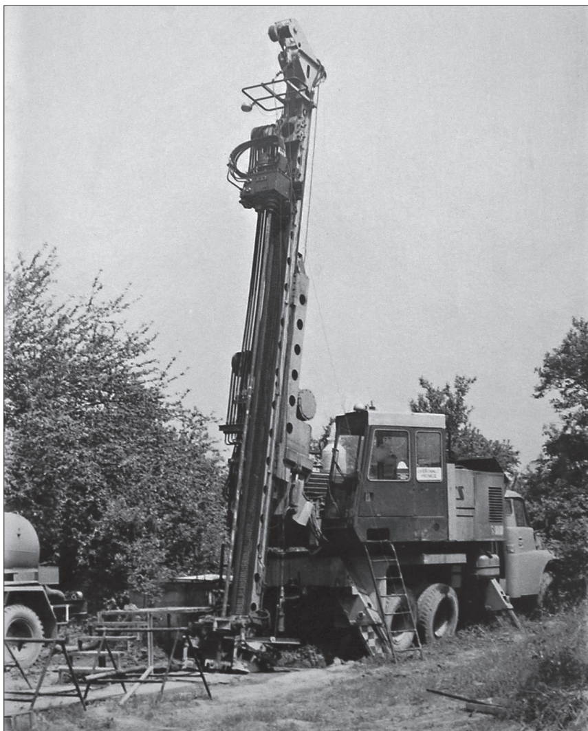
Obr. 5: Pojízdná vrtná souprava, která provedla vrt VLK-1. Ten prokázal pokračování pyritové struktury do hloubky více než 200 m. Foto K. POŠMOURNÝ.
