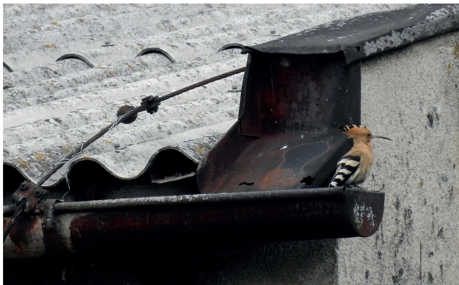
Obr. 5: Hnízdiště dudka pod střechou skladu píce a steliva v Olešnici. Vstup do hnízdního prostoru druhým obloukem vlnitého eternitu zprava, 22. 6. 2021. Foto: T. Diviš.
